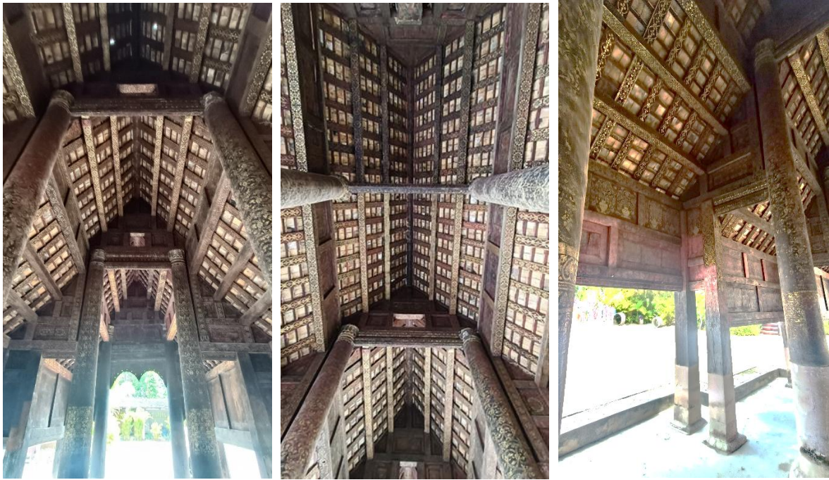
ภาพโครงสร้างเครื่องบน แบบล้านนา ของวิหารจามเทวี และการประดับฝ้าด้านด้วยภาพเขียนลวดลายรูปต่างๆ ด้วยเทคนิค ปิดทองร่องชาด (ปิดทองบนพื้นสีแดง) และปิดทองร่องรัก (ปิดทองบนพื้นดำ) บนโครงสร้างวิหาร ที่มา : ปริยานุช (๒๕๖๘)
