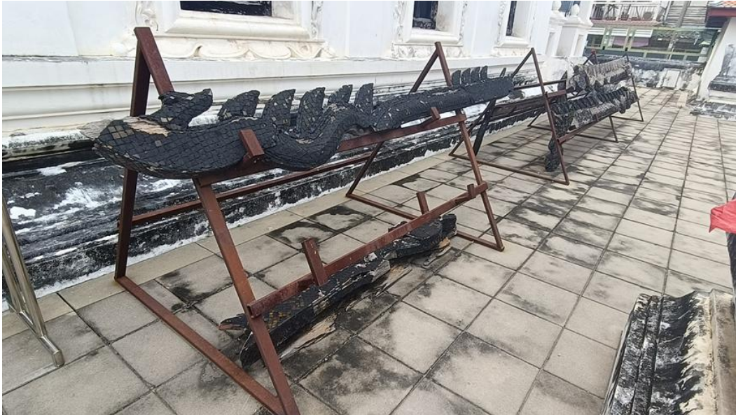
ภาพของเครื่องลำยองเดิมที่จัดแสดงอยู่ในพื้นที่กำแพงแก้ว ของพระอุโบสถ (หลังเก่า) แสดงถึงโครงสร้างที่เป็นไม้ มีร่องรอยการประดับกระจกปรากฏอยู่
