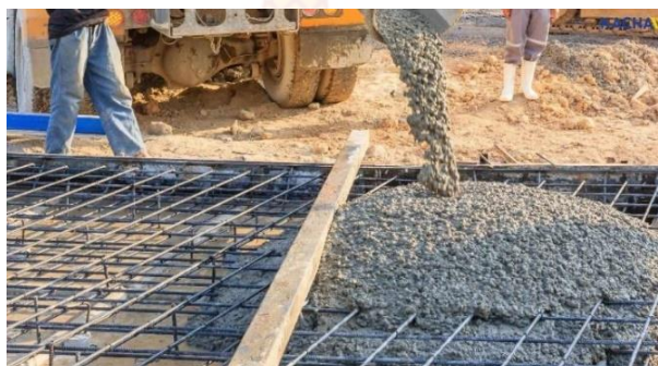
ภาพ 2.5 โครงสร้างคอนกรีตเสริมเหล็ก
