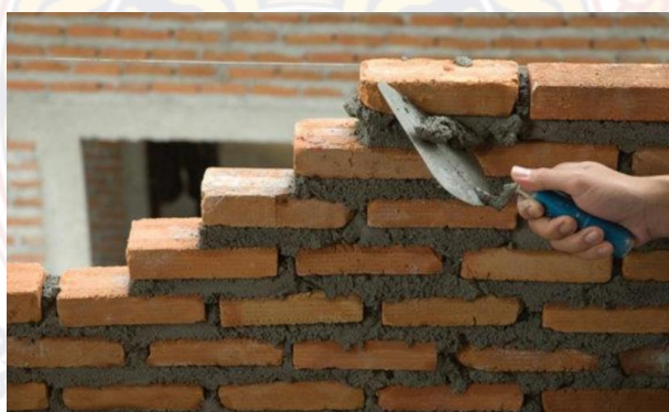
ภาพ 2.6 โครงสร้างผนังก่ออิฐฉาบปูน
