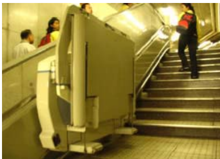
ภาพ 2.7 อุปกรณ์ช่วยในการขึ้นบันไดสำหรับคนพิการใช้รถเข็น ที่มา : http://www.scgexperience.co.th .
