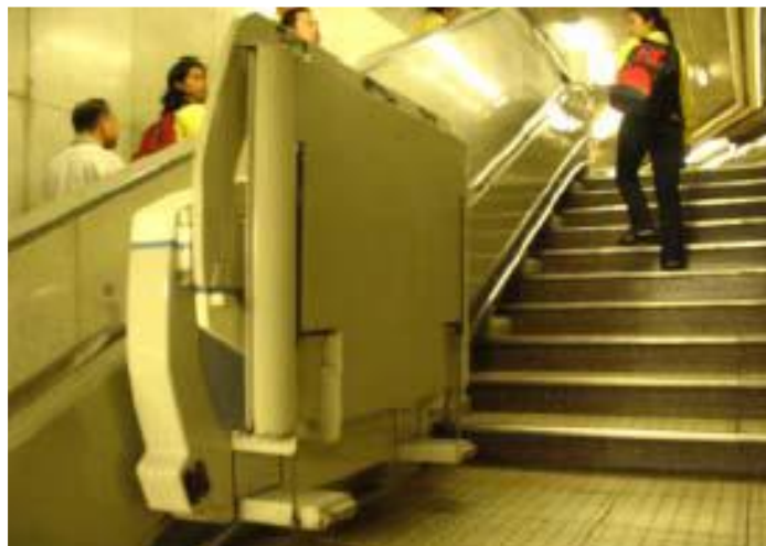
ภาพที่ 5 อุปกรณ์ช่วยในการขึ้นบันไดสำหรับคนพิการใช้รถเข็น
